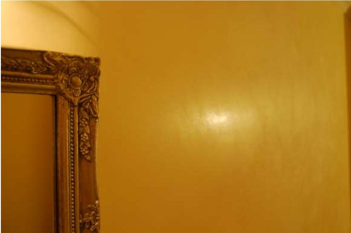
Kalkputztechnik „calce rasata“. Verpresster Kalk, eingefärbt und gewachst.
