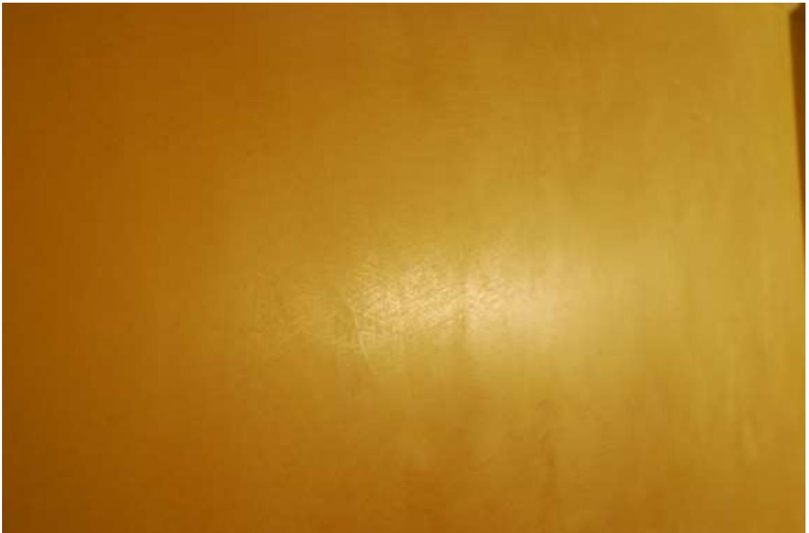
Detail „calce rasata“ Technik. Typisches Oberflächenbild mit Glanz-Mattstellen, sichtbare Spuren der Materialbearbeitung.
